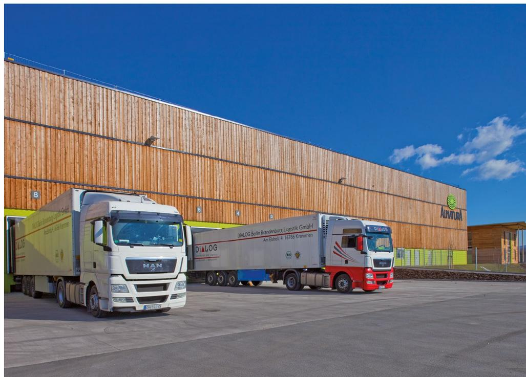
Auch große Sonderbauten wie das Hochregallager von Alnatura lassen sich als Holzbau ausführen. Das Lager wird mit mehr als 22.500 Sprinklern geschützt und wurde mit dem Award „Sprinkler Protected“ ausgezeichnet.
